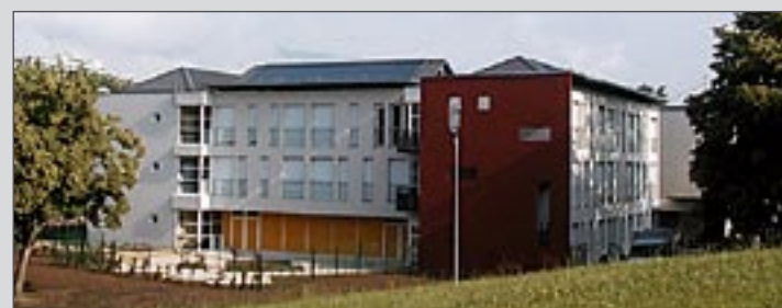
LES BERGES DE L'HYERES (73) MO : OPAC Chambéry BE : SETIC installateur : Ets INTHERSANT 66 m 2 de capteurs
