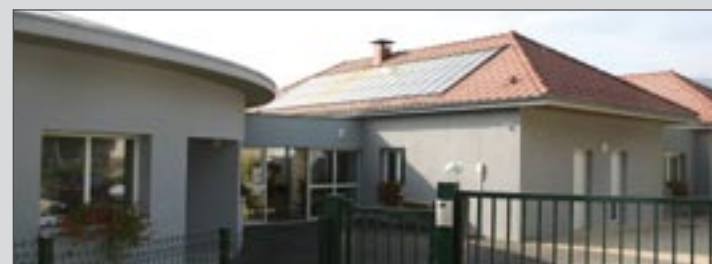
MAPAD de Chindrieu (73) MO : OPAC Chambéry BE : Philippe BRUN installateur : SYSTHERM 30 m 2 de capteurs
