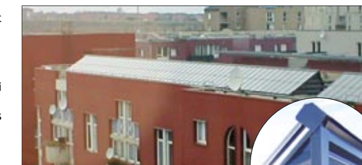
La Dentellière (38) 165 m 2 de capteurs MO : OPAC 38 Installateur : Ets ROUVRAY BE : GIRUS
